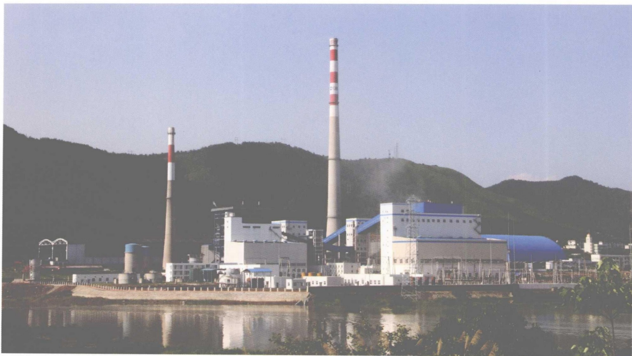
分宜发电厂首台国产210mW循环流化床机组厂区
