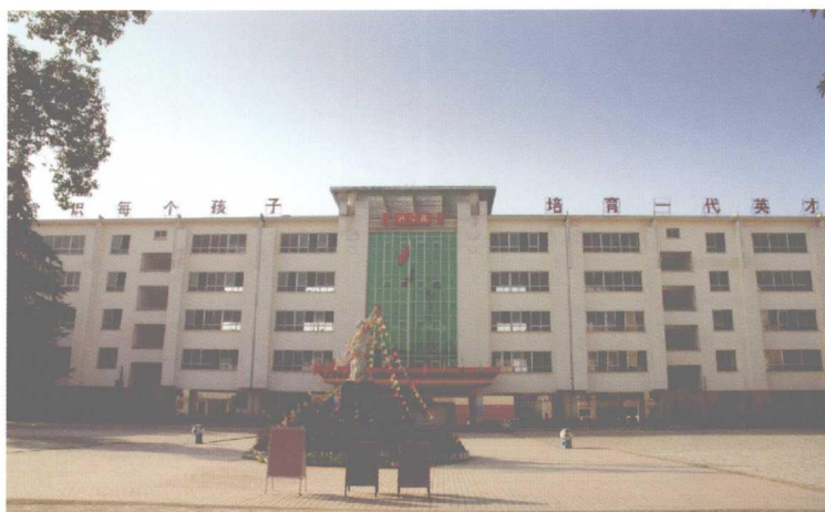
分宜一小教学大楼
