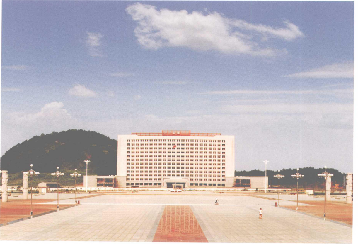
新落成的县行政中心大楼。
