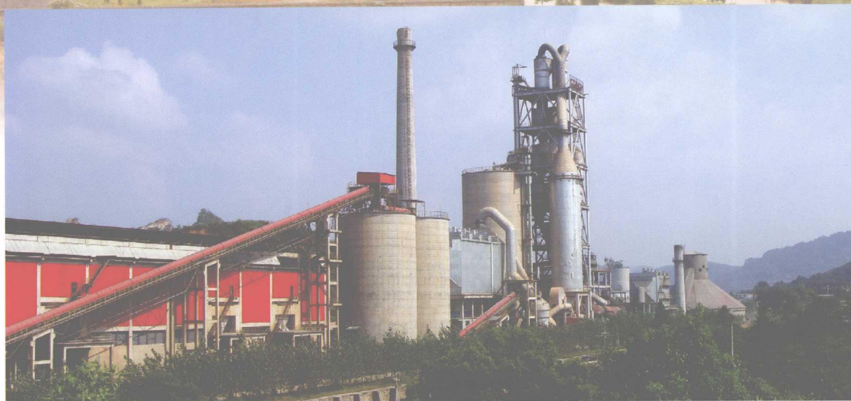
分宜海螺水泥有限公司新型水泥干化熟料生产线
